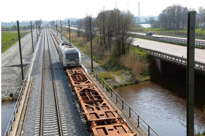
Es geht voran: Ausbau und Elektrifizierung der Bahnstrecke Oldenburg-Wilhelmshaven sowie der Bau der Bahnumfahrung Sande sind in vollem Gange.
